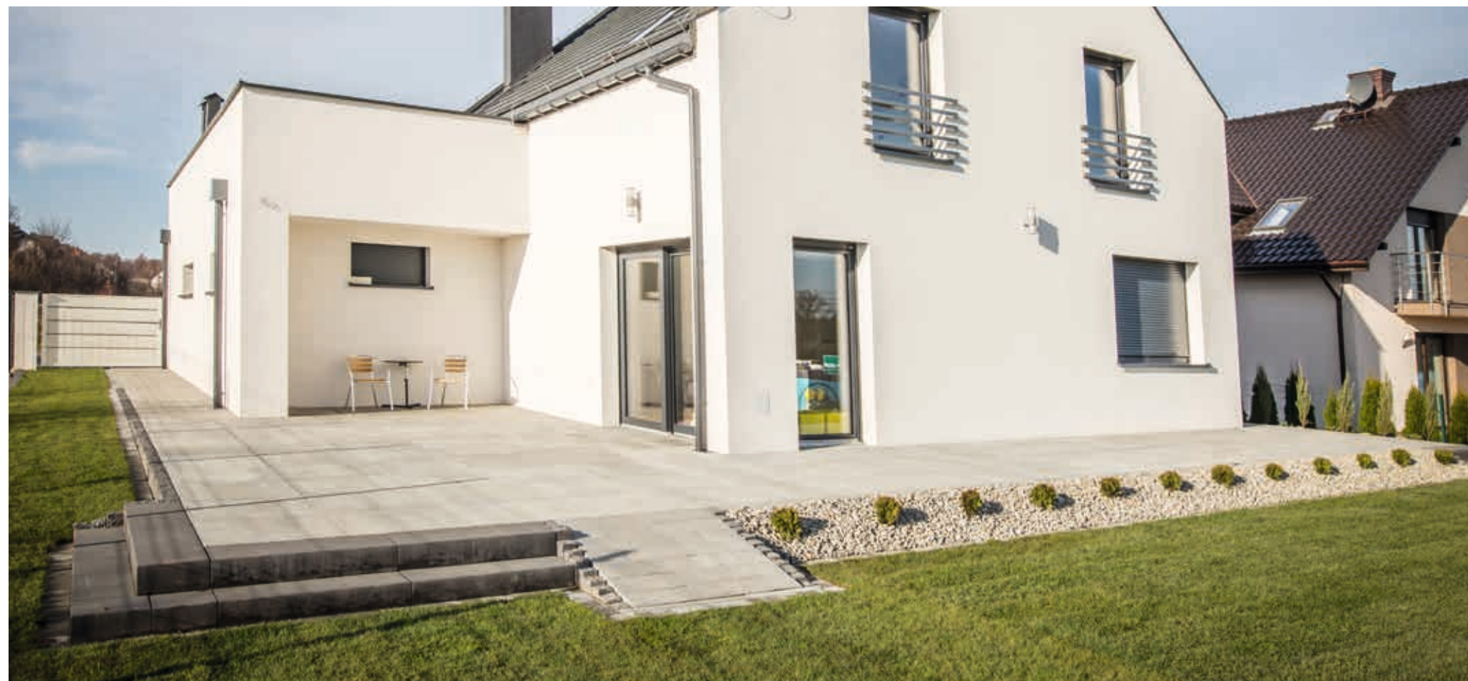
wykonanie: QOSTKAPROJECT Sp. z o.o. Chelmek
