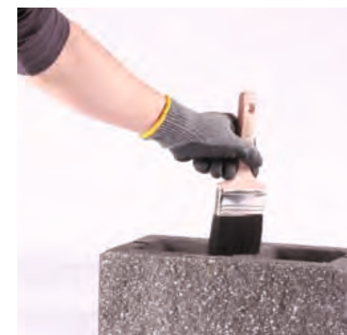
KROK 1 Oczyszczenie powierzchni
